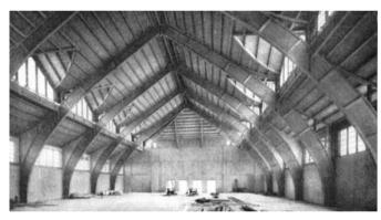
Bild 9. Ausstellungshalle der Internationalen Bauausstellung Leipzig, später genutzt als Halle in Wilhelmshaven, Spannweite 25 m, Binderabstand 6,25 m, Querschnittshöhe 1,1 m, Herstellung und Montage in 4 Wochen, 1913 [12] Fig. 9. Hall for the international building exhibition in Leipzig, later reerected in Wilhelmshaven, span 25 m, distance of spacing between trusses of 6.35 m, high of cross section 1.1 m, hall was prefabricated and erected in 4 weeks [12]
