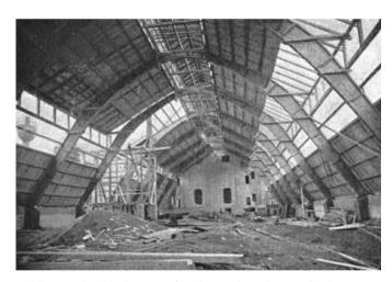
Bild 6. Rohsalzschuppen für das Kaliwerk Steinförde, Spannweite 22,5 m, 1910 [5] Fig. 6. Salt depot for a factory in Steinförde, span 22,5 m, 1910 [5]
